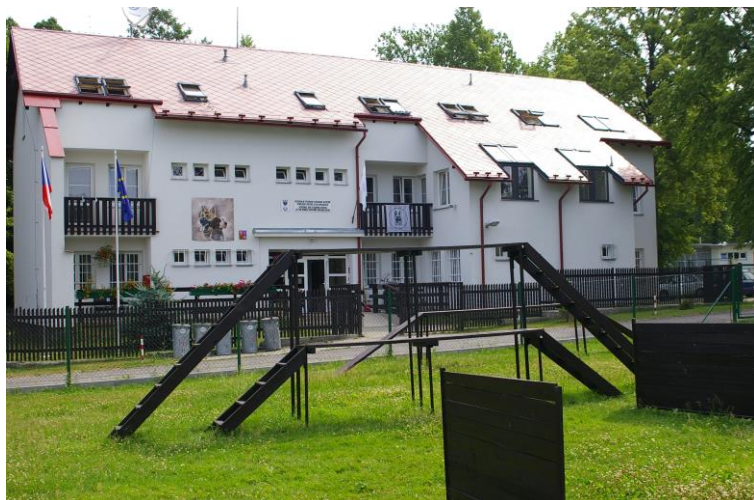
Dokončená rekonstrukce hlavní budovy, 2005
