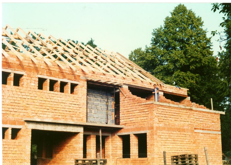
Výstavba hlavní budovy VZSK
